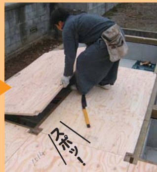
パネル敷込み
