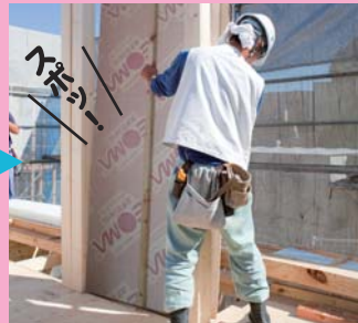
パネル入れ込み
