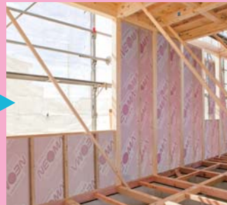
パネル入れ込み完了
