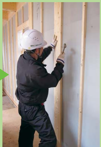
釘打ちでパネル留め
