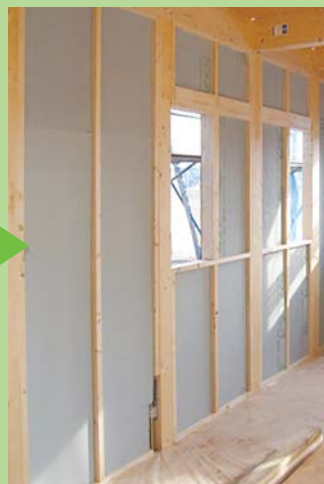
パネル入れ込み完了
