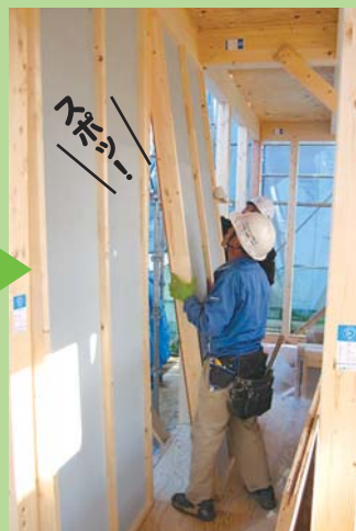
パネル入れ込み
