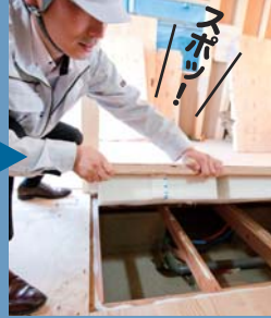
パネル敷込み
