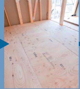
パネル敷込み完了
