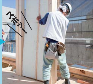
パネル入れ込み
