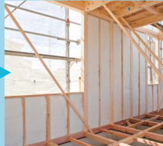
パネル入れ込み完了
